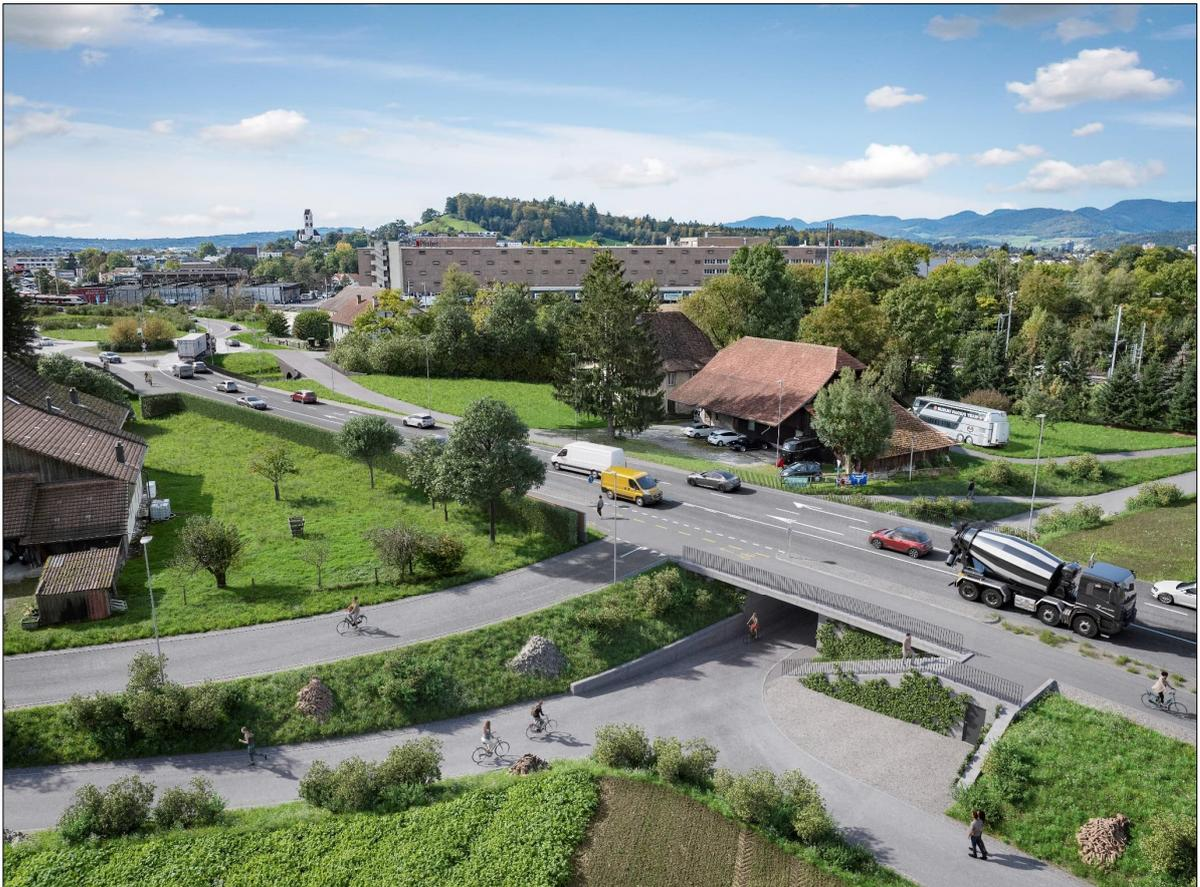
Weiter wird der Anschluss Süd der Überführung B-178 an die bestehende K235 Bernstrasse Ost sowie der gesamte Bereich zwischen dem Gebäude Möbel Pfister und dem Parkhaus neugestaltet. Der bestehende Bahnübergang auf der K235 wird dank der Überführung aufgehoben und rückgebaut. Die neuen Anlagen für den Fuss- und Veloverkehr, die Anpassung des bestehenden Velonetzes und
