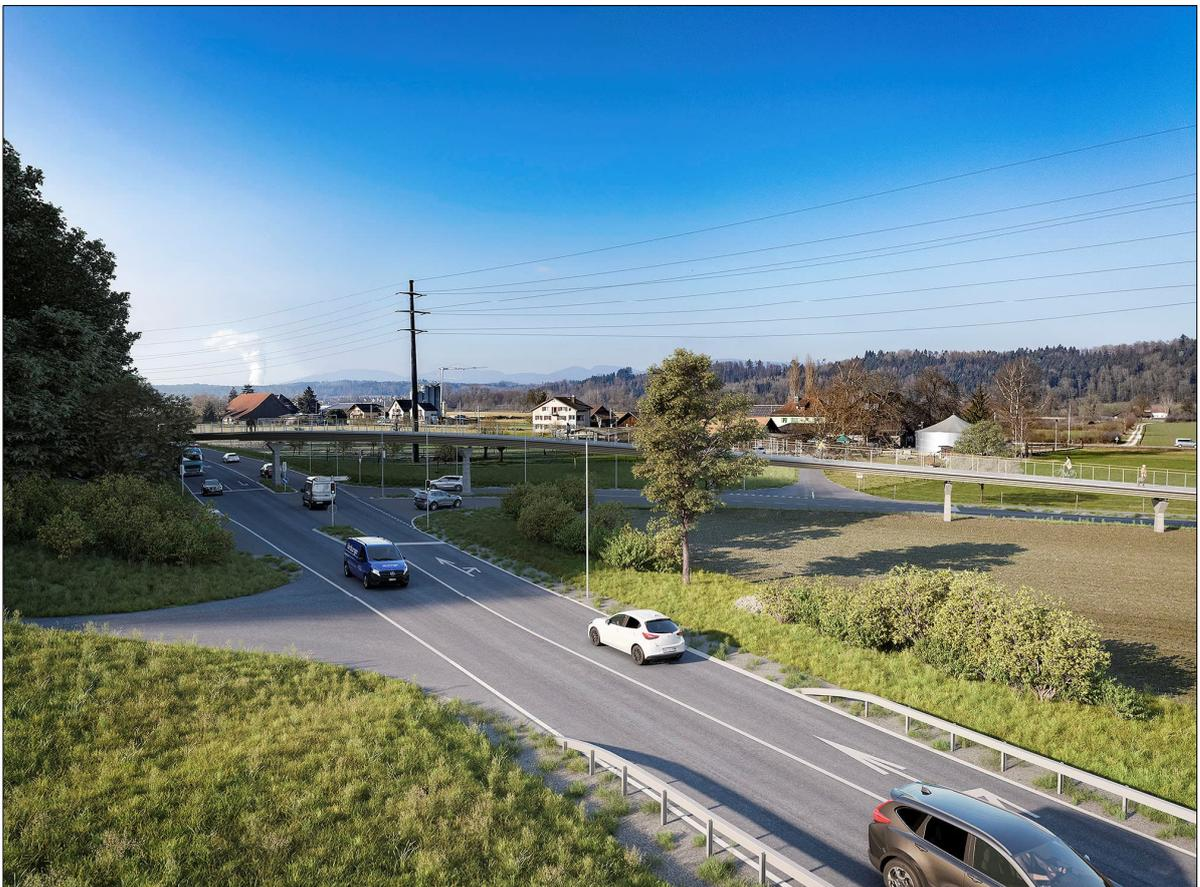
Vom Knoten Hürdli wird die NK240 an die Autobahn A1 geführt. Der A1 folgend, führt die Kantonsstrasse in erhöhter Lage zum Freileitungsmast Nr. 39 der Swissgrid AG, unter der neuen Überführung Langmattweg (N1-215) à Niveau hindurch bis zum Knoten Helgefild. Der Freileitungsmast wird hierbei einbetoniert, um trotz der geringen Abstände zum Fahrbahnrand einen genügenden Anprallschutz zu gewährleisten.
